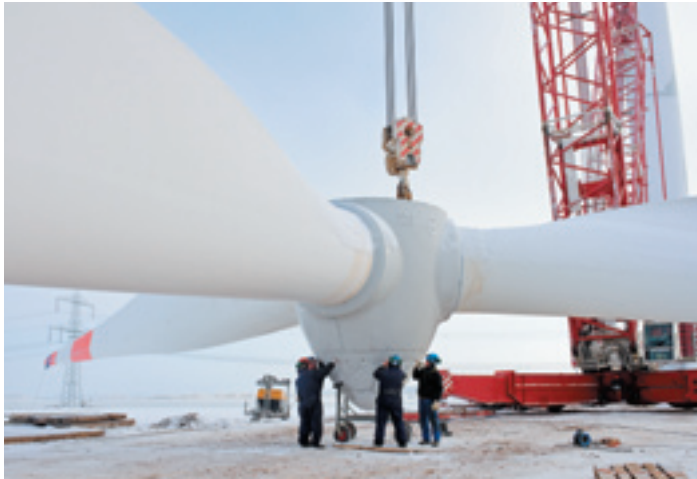
45 Meter Flügellänge, 105 Meter hoher Stahlurm: eine der vier neuen Mühlen im Windpark Ketzin wird montiert.
