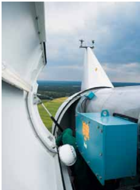
Sascha Schnabel setzt den Helm auf, schnallt den Klettergurt um und erklimmt die Leiter im Inneren des Turms – 210 Sprossen senkrecht in die Höhe.
